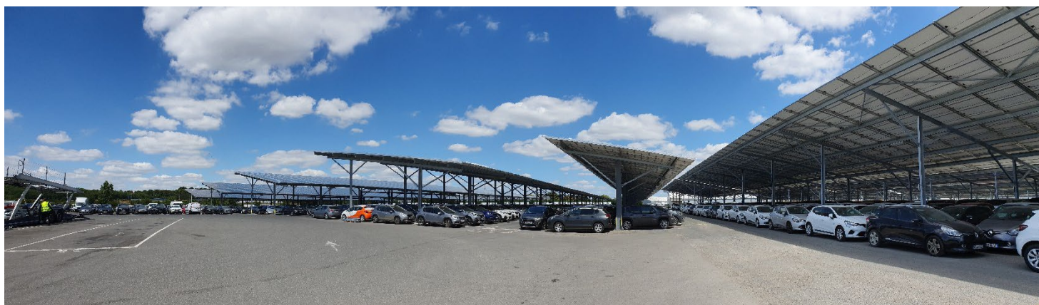
Ombrières TEA Fleury - Crédit Photo : Valeco
