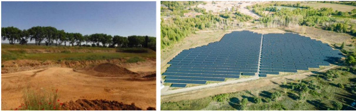
Aperçu du site avant et après les travaux. Ce terrain est une propriété de la Société Languedocienne d'agrégats (Solag) qui a grandement facilité la faisabilité du projet.
