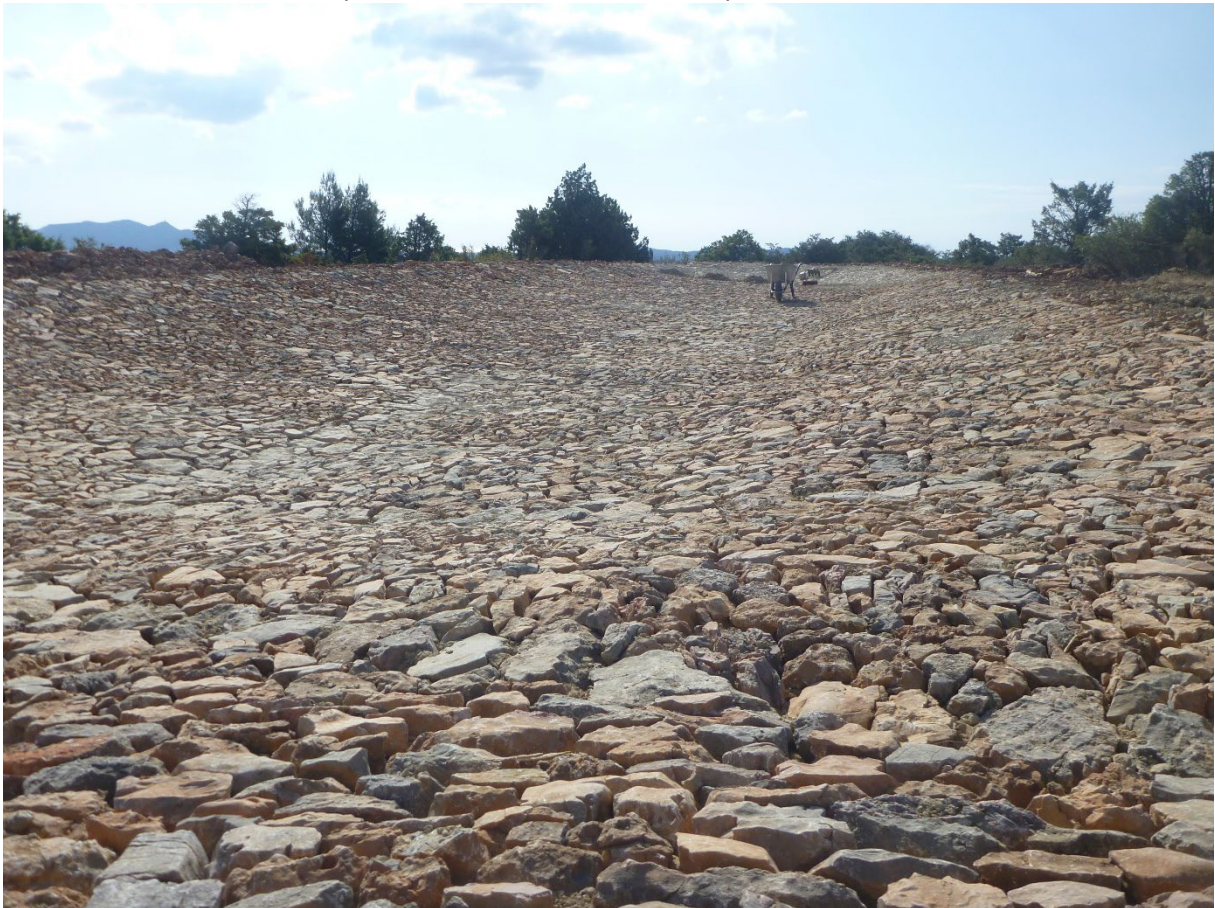
Création d'une lavogne de 200 m2 en pierre sèche joint argile (© CEN Occitanie/Lionel Courmont)
