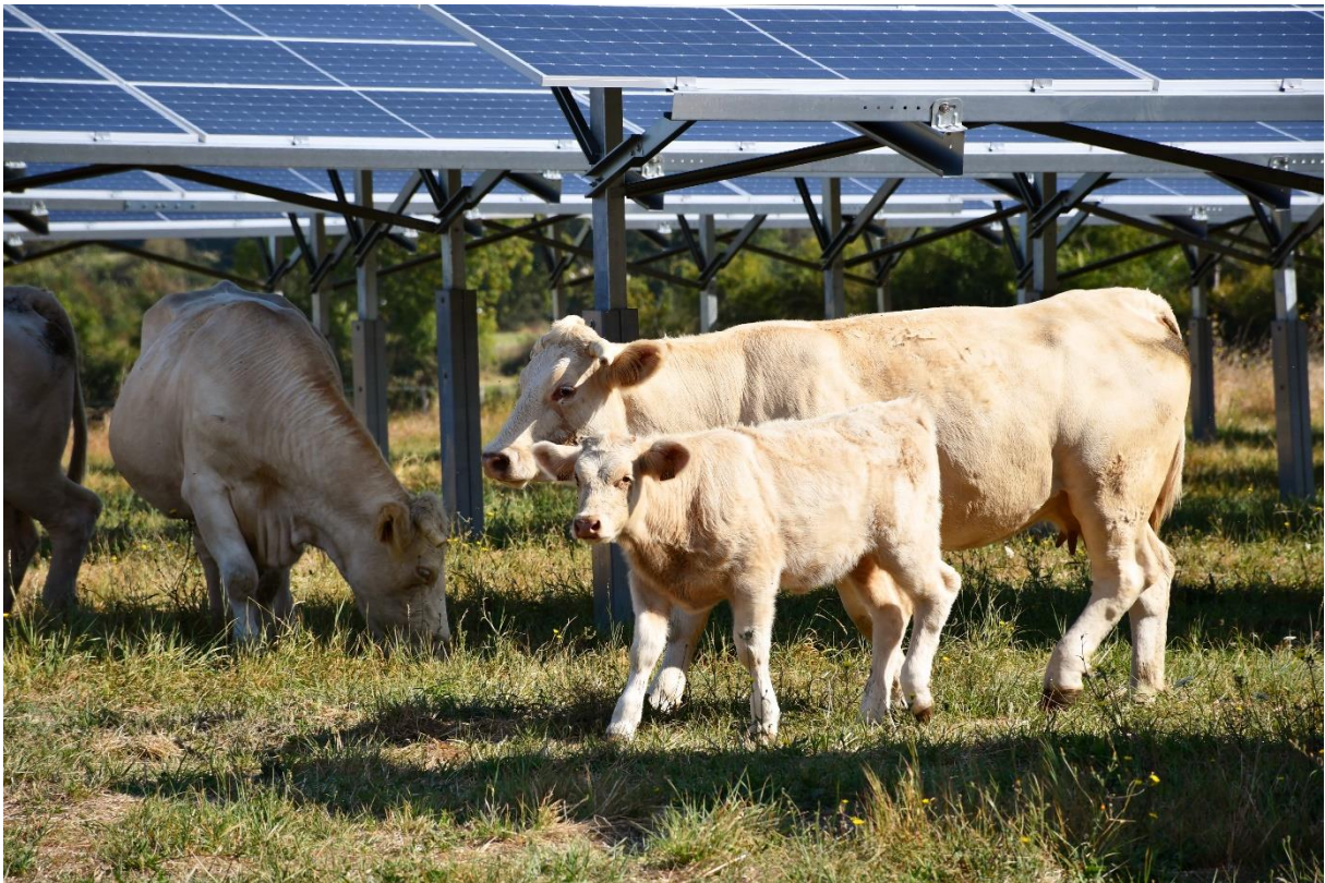
Démonstrateur agrivoltaïque AgroCi'nergies de VALECO à Champagné-Saint-Hilaire, Vienne (86)
